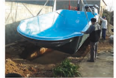
Colocación depurador.
